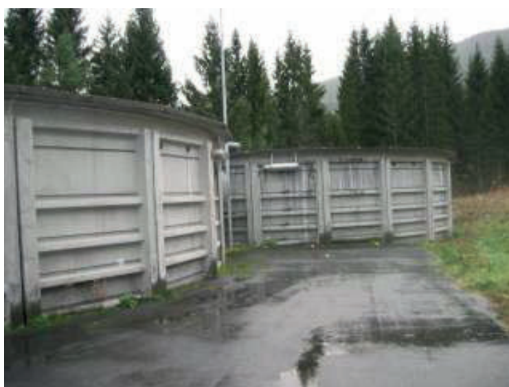
Figur 1. Renseanlegg for biologisk forbehandling av avløpsvann fra en næringsmiddelbedrift
