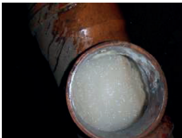
Figur 2. Eksempel på prøvetakingspunkt ved påslipp av prosessavløpsvann fra en meieribedrift
