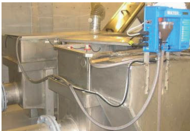
Figur 17. Eksempel på sugeslange som har en uheldig framføring (to svanker)
