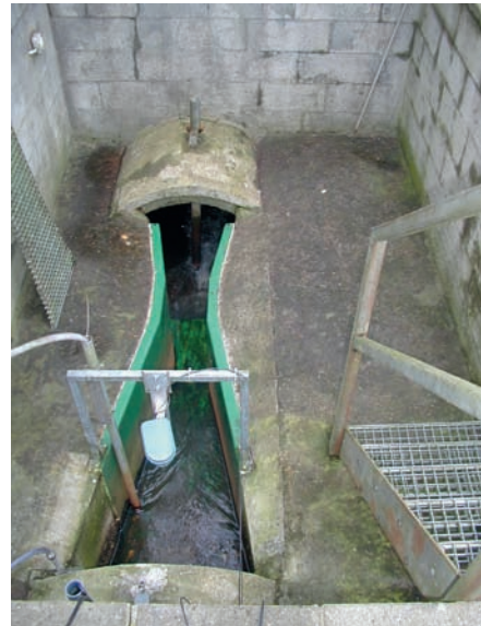
Figur 27. Plan og snitt av en Parshallrenne, samt foto som viser en Parshallrenne i drift på et renseanlegg
