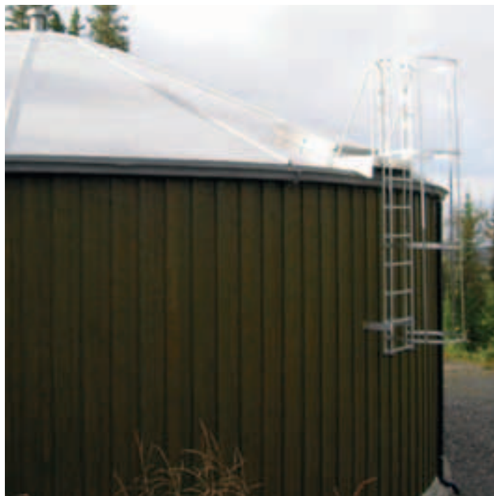
Figur 6.19. Luke på skrått tak i glassfiberelementer.
