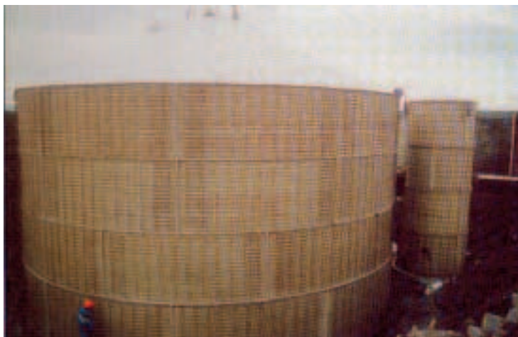
Figur 6.4. Glassfiberbasseng med utvendig betongvegg under oppførelse. Bildet er hentet fra /19/.
