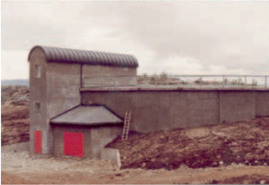
Figur 6.1: Høydebasseng Alta vannverk. Vannvolum 8500 m 3 . To vannkammer, bygd med konsentrisk indre basseng. Bassenget er delvis nedfylt. Yttervegg er utført med etterspent armering. Yttervegg har pusset isolasjon. Ventilammer går inn under bunnplate. Trappehus er ført opp til tak. Trappehus er forlenget med eget bygg innover taket. Adkomst til begge kammer med trapp fra dette bygget. Taket er isolert med støpt dekke over. Det er adkomst til tak for publikum fra terreng på baksiden.
