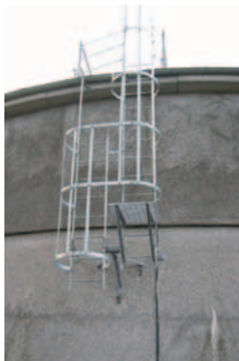
Figur 6.23: Utvendige ledere. Bilde til venstre viser bruk av løs stige for å hindre uvedkommende å ta seg opp på tak. På bildet til høyre er vist en løsning på leder med repos. Vær obs. på at større snømengder vil heve "bakkenivået".
