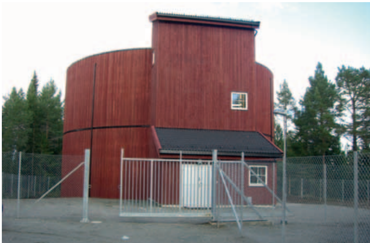
Figur 13.7.1 Klæbu kommune. Lauvåsen høydebasseng. 2006. Volum 2500 m 3 . Plastøpt betong kledd med panel.
