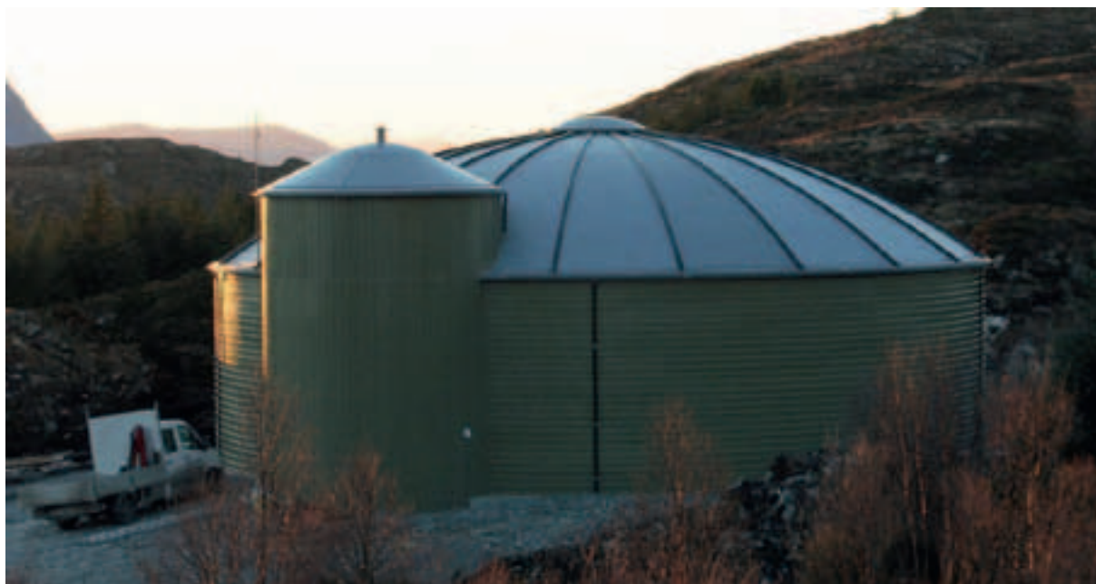
Figur 13.7.2 Herøy kommune. Volum 2100 m 3 . Prefabrikkert basseng i glassfiberelementer. Støpt forsterkningsvegg med utvendig glassfiberforskalning.
