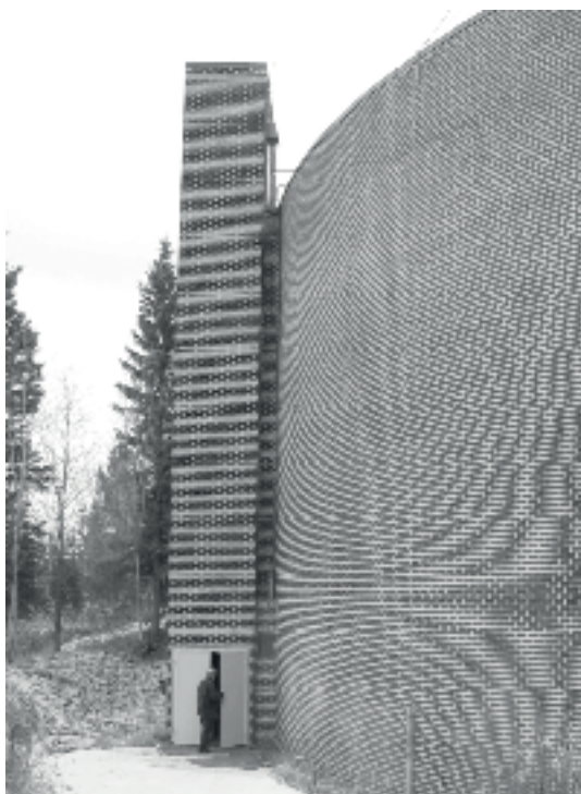
Figur 6.15: Huseby høydebasseng Trondheim kommune. Vannvolum 22.000 \text{ m}^3 . Utvendig forblendet med tegl.
