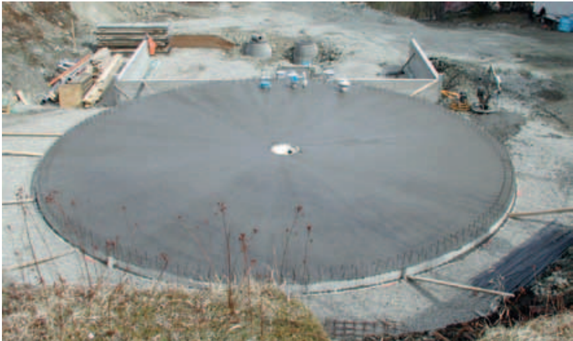
Figur 6.9: Støpt bunnplate for montering av glassfiberelementvegger.
