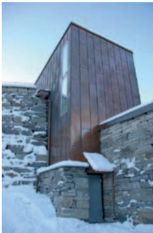
Figur 6.16: Herlofsenløypa høydebasseng, Trondheim kommune. Vannvolum 2.600 m 3 . Utvendig forblendet med bruddstein.
