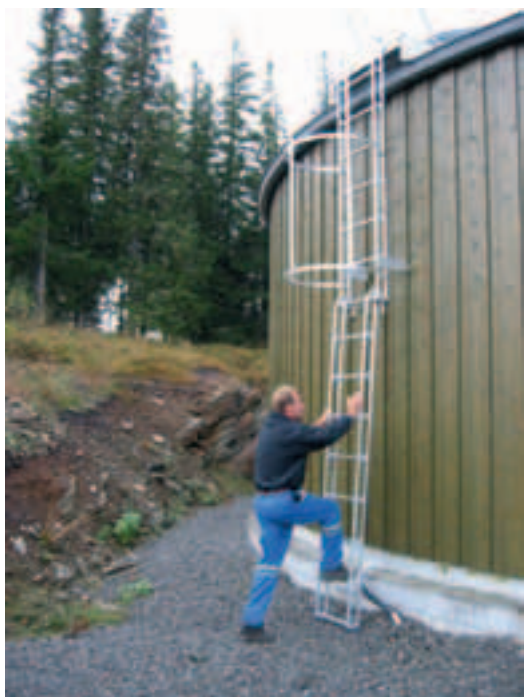
Figur 6.23: Utvendige ledere. Bilde til venstre viser bruk av løs stige for å hindre uvedkommende å ta seg opp på tak. På bildet til høyre er vist en løsning på leder med repos. Vær obs. på at større snømengder vil heve "bakkenivået".
