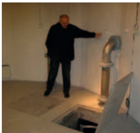
Figur 6.21. Takbygg over nedstigingsluker. Vikåsen høydebasseng. Trondheim kommune. Innvendig trapp fra ventilkammer opp i takbygg. Luker kunne med fordel vært montert med sarg for å unngå spyling ned i vannkammer ved renhold. Ventilering er uten filtrering av luft, samt at det er mulig å føre inn en slange i ventilasjonsrøret.
