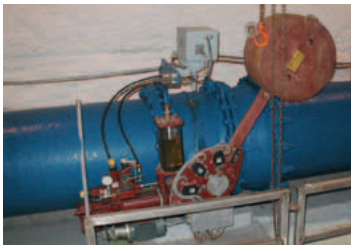
Figur 7.3: Rørbruddsventil (falloddsventil)
