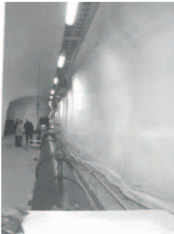
Figur 6.31: Adkomsttunnel og damplate. Høgåsen basseng. Trondheim. Ferdig 1993. 22 000 m 3 vannvolum.
