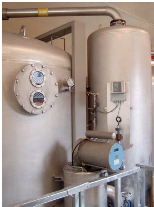
Figur 4. Ozonering-biofiltreringsanlegg i lukket tanksystem.
