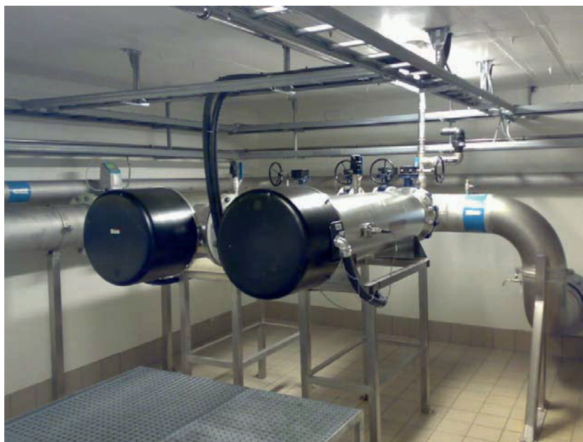
Figur 6. UV-anlegg (av lavtrykks type)
