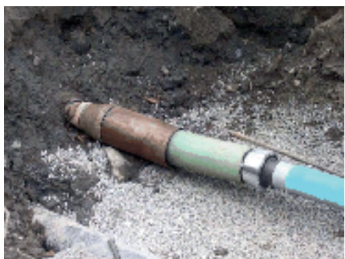
Figur 12: Klar for inntrekking av første rør!
