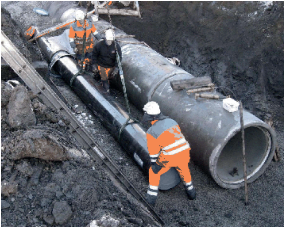
Figur 6. Duktile støpejernsrør med sink og utvendig PE-belegg brukt i grøft med alunskifer
