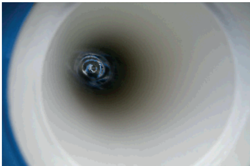
Figur 10. Innvendig belegg av polyuretan (PUR)
