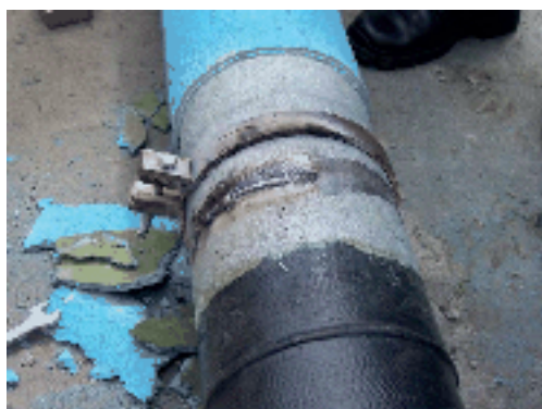
Figur 11. Spissenden av et duktilt støpejernsrør med sveiselarve fra fabrikk, og med bitumenbelegg (nærmest). Lenger inn på røret er det vist at det også er mulig å sveise på ny sveiselarve; sementmørtelbelegget er fjernet, sinkbelegget er slipt bort der det skal legges på sveiselarve. Ny sveiselarve er påbegynt (venstre side av røret). (Røret kan nå kappes.)
