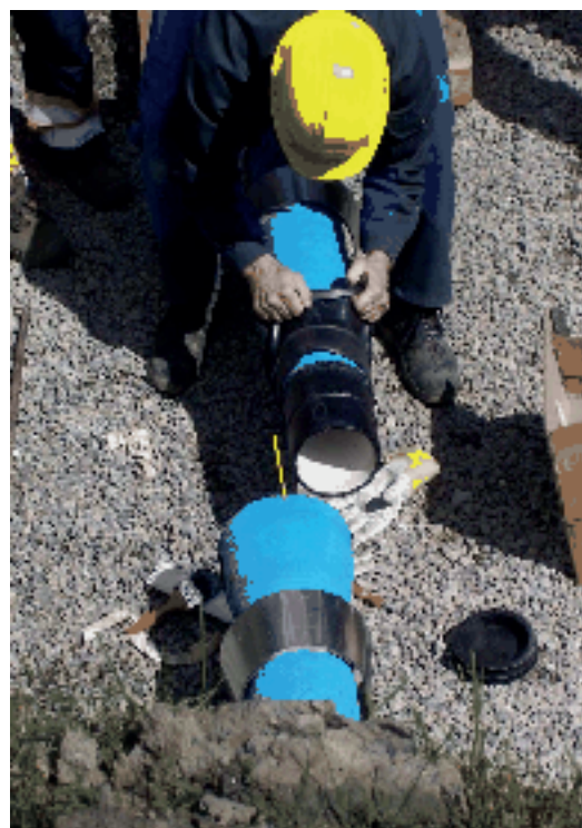
Figur 13. Bildet over viser montering av nytt rør som skal låses fast til det allerede inntrukne røret. Legg merke til gummimuffen på det nye røret som skal trekkes inn og som skal trekkes over rørmuffeskjøten, og den koniske beskyttelseskappen i aluminium ved muffen på røret som allerede er trukket inn, og som skal plasseres over rørmuffe og gummimuffe (alternativt PE-krympemuffe) for å lette inntrekkingen av det nye røret.
