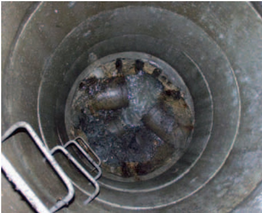
Figur 11: Kum med dårlig innløpsarrangement og manglende bunnrenne (Foto: Leif Sigurd Hafskjold)
