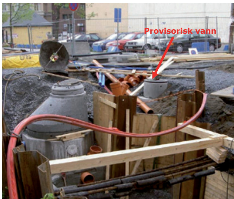
Figur 14: Provisorisk vannledning er en liten del av et stort prosjekt, men er forsyningsmessig og hygienisk viktig.
