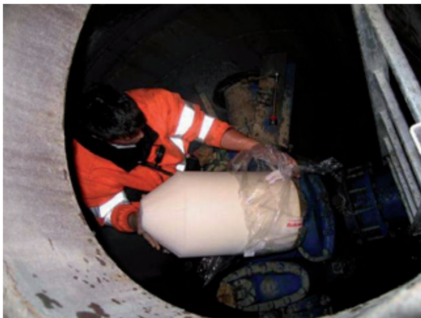
Figur 13: Spyling med myke renseplugger: Viktig at plastinnpakning fjernes nede i kum, og like før rensepluggen føres inn i vannledningen.
