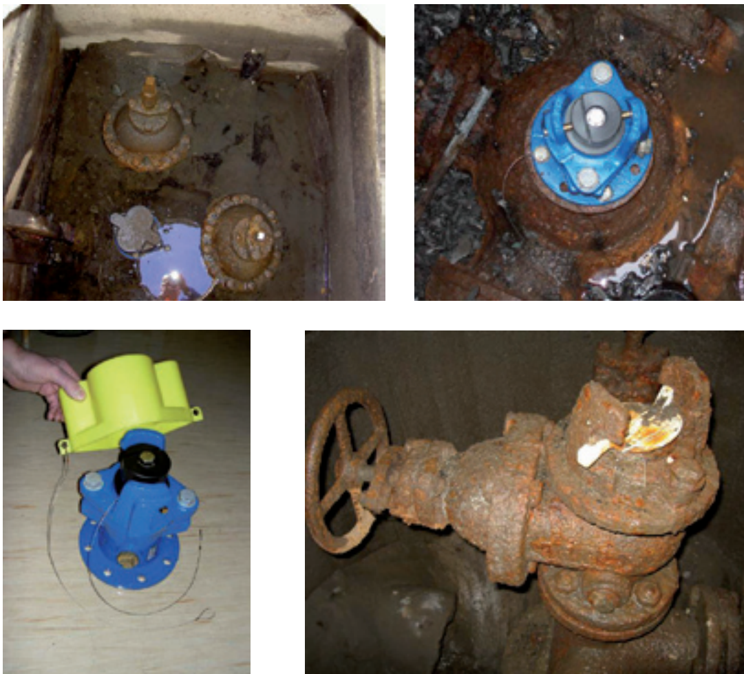
Figur 6: Eksempler på bruk av brannventilsikring og sluseventil for å unngå tilførsel av forurensning via brannventil.
