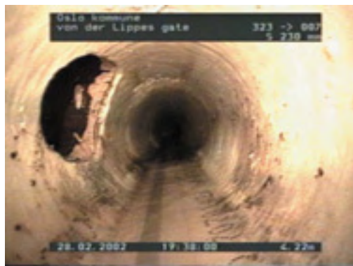
Oppfrest tilkopling på renovert ledning.
