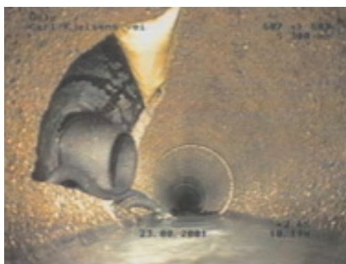
Sadelgren med innhugget hull.
