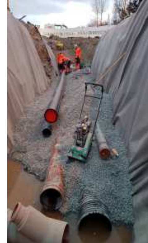
Bilde fra Vannspeilet 2-21
