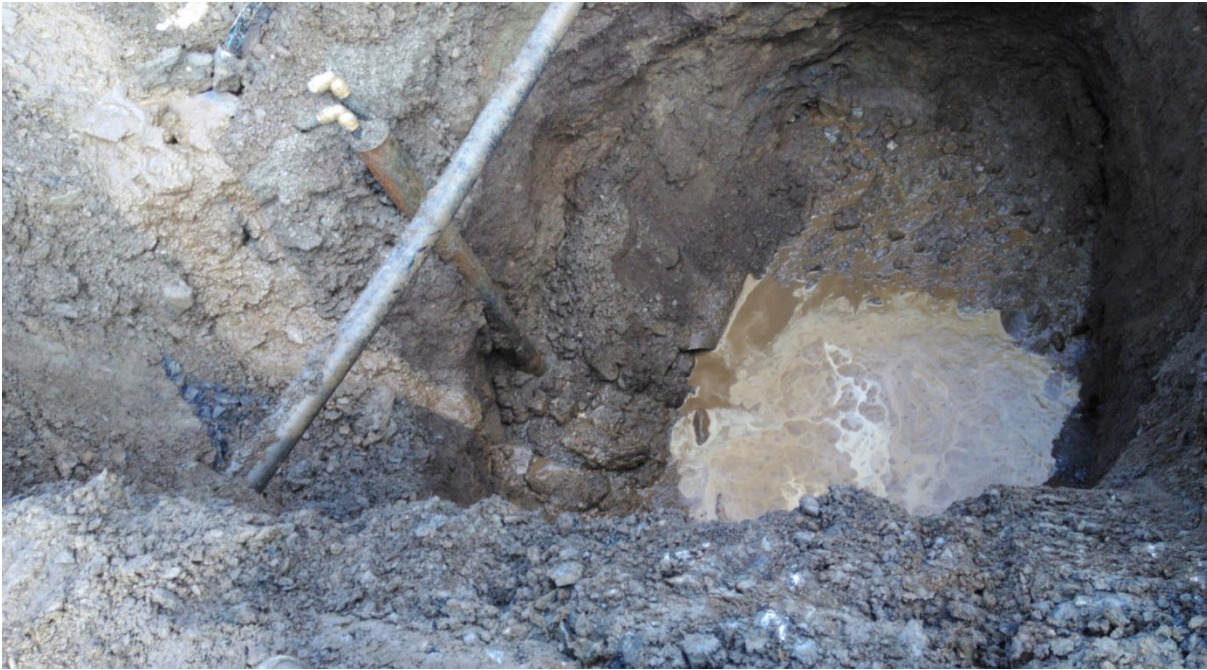
Gjennom boring av kommunalt VA. Her en 300 mm i Lindhaugsvingen i Bærum. Foto: Bærum kommune.
