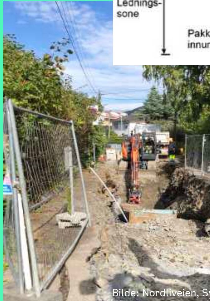
Figur 3: Eksempel på ettrørsgrøft (foto: Basal).
