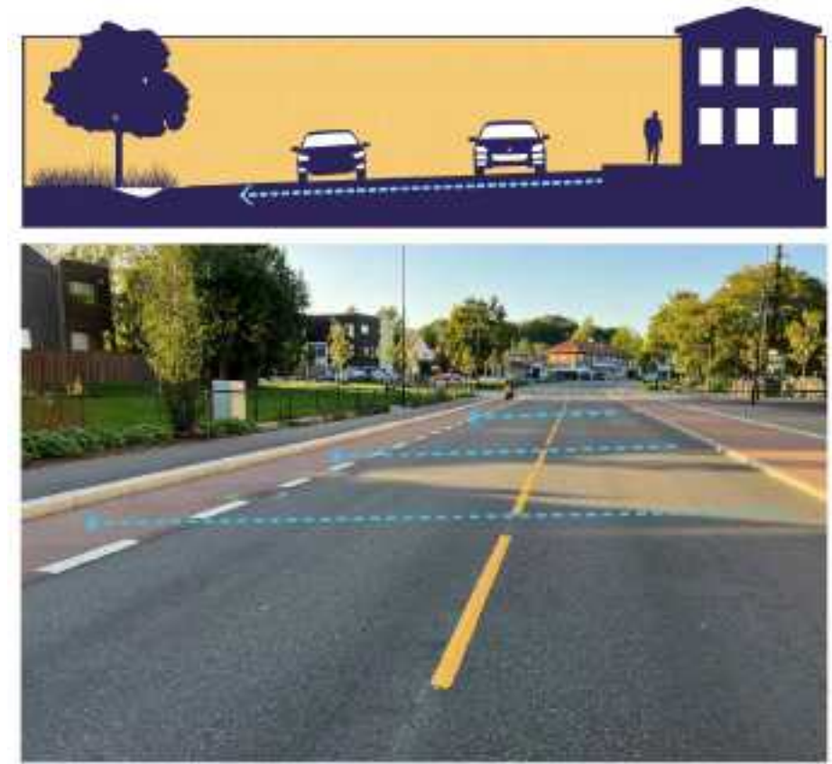
Bilde 4.2: Erstatning av vannveier i gater (Foto: Rambøll)
