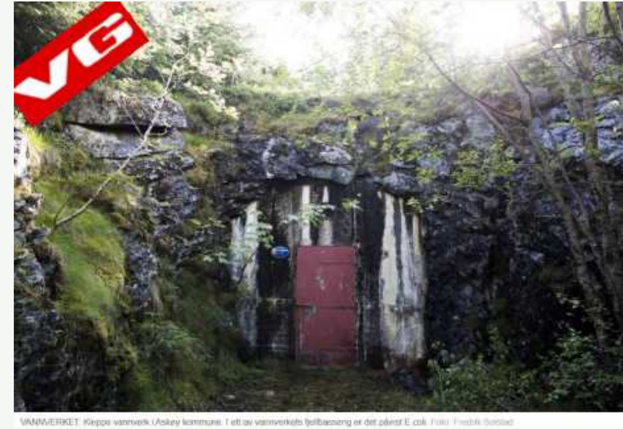
VANNVERKET. Kjøppe vannverk (Åsøy kommune). I ett av vannverkets fjellbasseng er det påvist E.coli. Foto: Fredrik Sørlied
