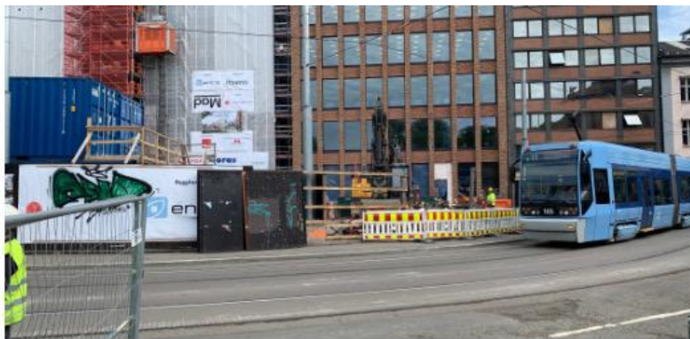
Byggingen av nytt juridisk fakultet på Tullinløkka i Oslo går mot slutten, men rettsstriden mellom kommunen og utbygger vil muligens kunne pågå en stund til. (Foto: Kjetil Kolsrud)
